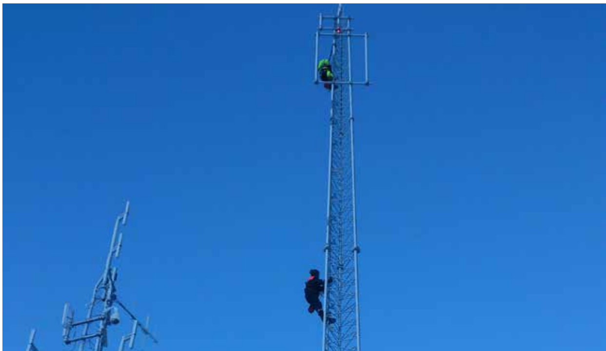
Radiomast Storheia Foto: Trollfjord Kraft
